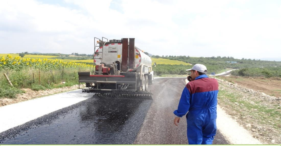
MERKEZ KAZMACALI 1. KAT ASFALT
